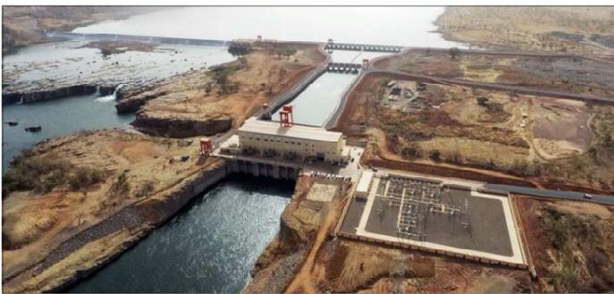
Neuvième plus long cours d'eau en Afrique, le fleuve Sénégal comprend plusieurs barrages, dont celui de Gouina de 1 347 mètres de long. Il a été réalisé en amont de Kayes avec une centrale électrique au fil de l'eau d'une puissance de 140 mégawatts et il fournit déjà de l'électricité depuis plusieurs mois car il a été connecté au réseau électrique de la Guinée, du Mali, de la Mauritanie et du Sénégal en mars dernier.
